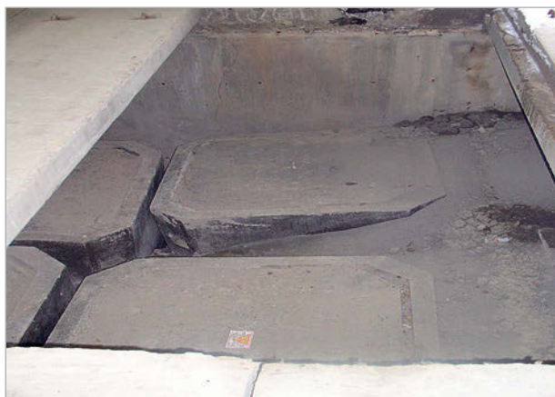
Рис. 2. Размещение упаковок РАО в отсеке ПЗРО
