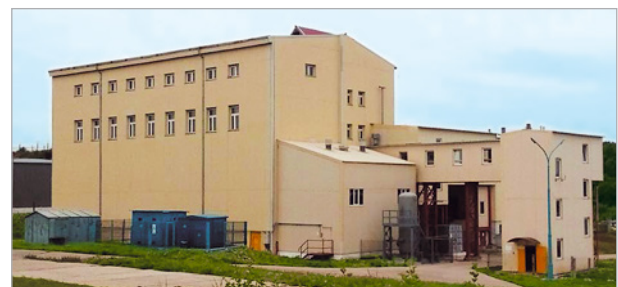
Рис. 1. Комплекс по переработке ЖРО
