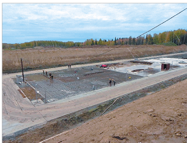
Рис. 1. Строящийся пункт приповерхностной изоляции радиоактивных отходов
