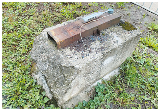
фрагмент фундаментного основания
