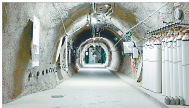
Рис. 3. Выработка внутри ПИЛ Монт-Терри в Швейцарии [5]
