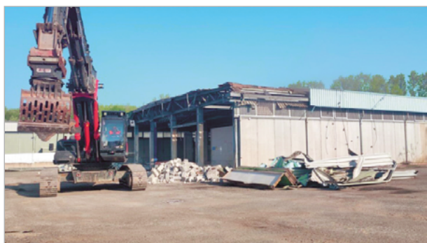
Рис. 1. Здание ПХ ERSBA 1 на площадке АЭС «Каорсо» [2]
