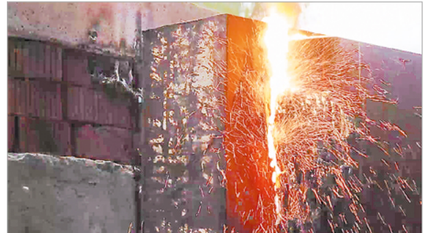
Рис. 1. Резка стального листа толщиной 200 мм
