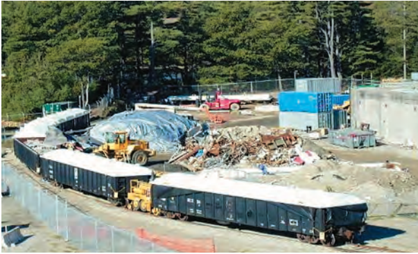
Рис. 3. Погрузка отходов при выводе из эксплуатации АЭС Maine Yankee [17]
