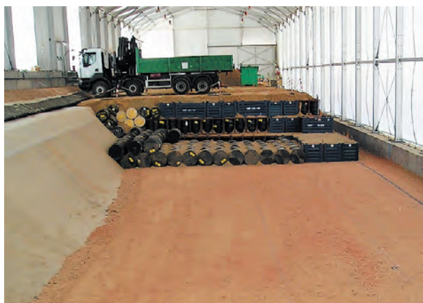
Рис. 2. Общий вид одной из траншей хранилища ОНАО в El Cabril [15]
